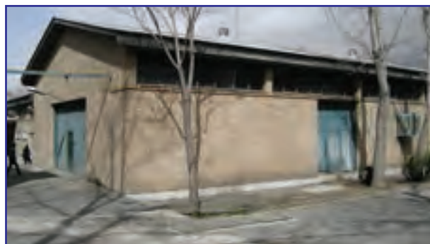
شکل ۱-۳ ساختمان قسمتی از کارخانه
