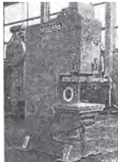
شکل ۲-۱۳ پرس انتها باز با دهانه قابل تنظیم
